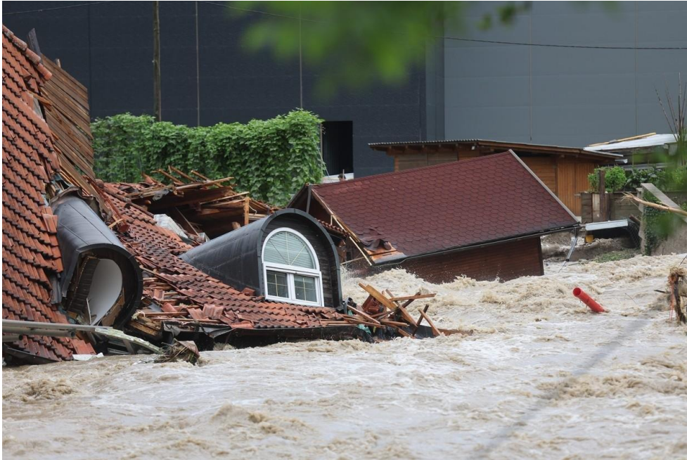
Kuva 17 Osa rakennuksista tuhoutui täysin.
